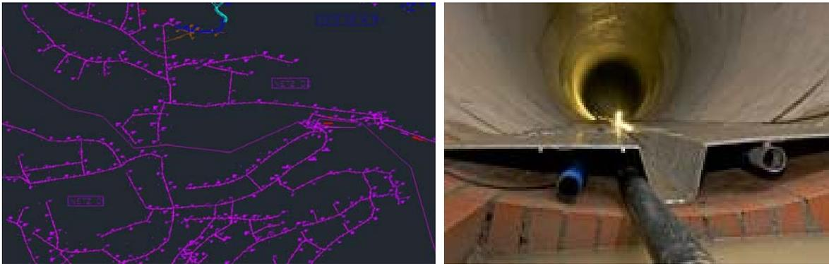
Abbildung 9: Abwasserkanalnetz Wüstenrot (links), Wärmetauscher im Abwasserkanal (rechts) (Foto: Stadtwerke Bochum)
